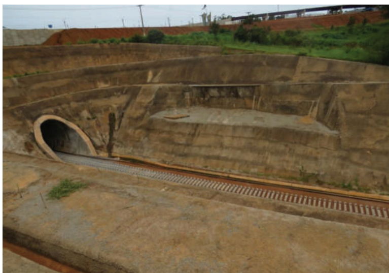
Figura 4 - Túnel 2 da ferrovia Norte-sul em Anápolis.
