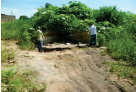
Foto 4. Lançamento de boca de lobo em dezembro de 2013.
