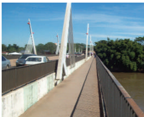
Figura 4. Ponte sobre rio Araguaia, meio de tráfego entre três municípios e dois estados, GO / MT.
