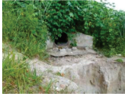
Foto 5. Lançamento de boca de lobo em fevereiro de 2014.
