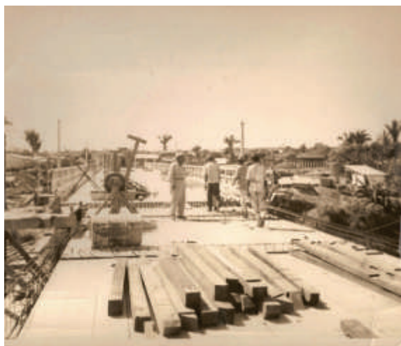
Figura 3. Construção das pontes sobre os rios Araguaia e Garças/ Fundação Brasil Central.
