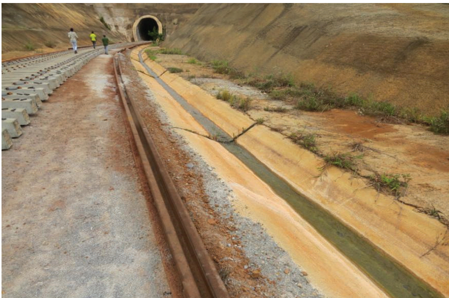
Figura 5: Nascente do ribeirão das antas saindo do túnel da ferrovia.
