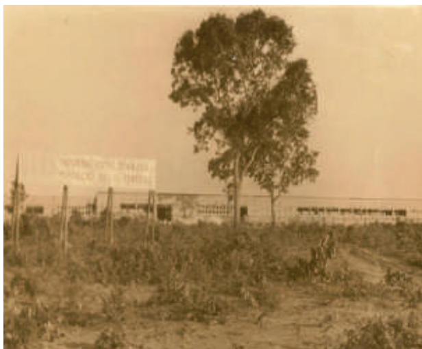
Figura 9. Construção do hospital Getúlio Vargas
