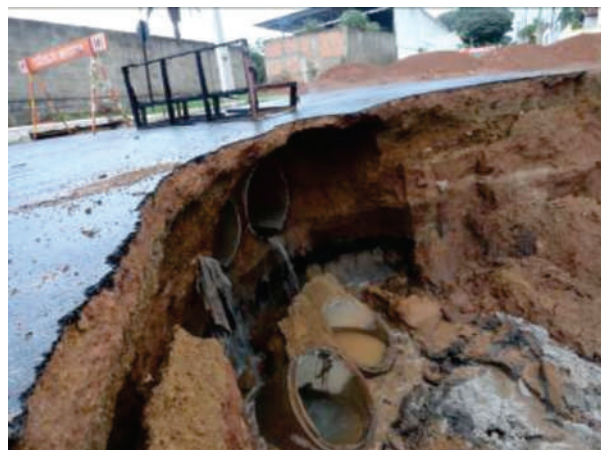
Foto 7. Fluxo de água pluvial na galeria durante evento pluviométrico, sob a Avenida Wolney P. Santos.
