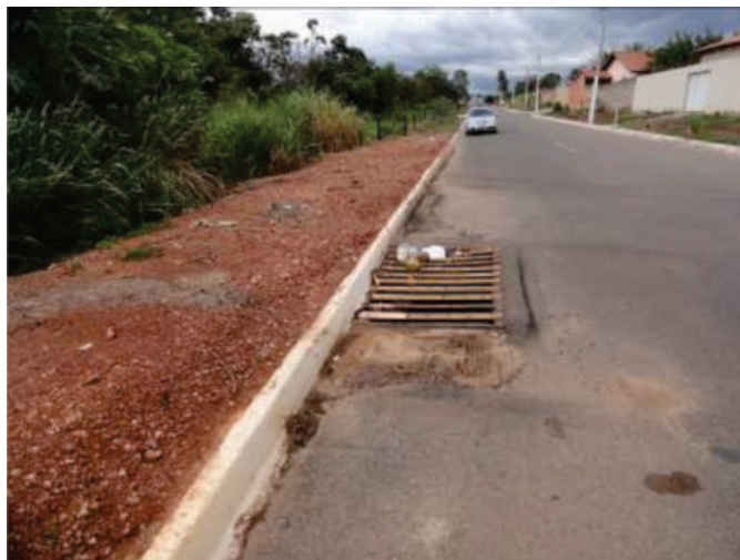
Foto 1. Vista parcial da boca de lobo na rua 6.
